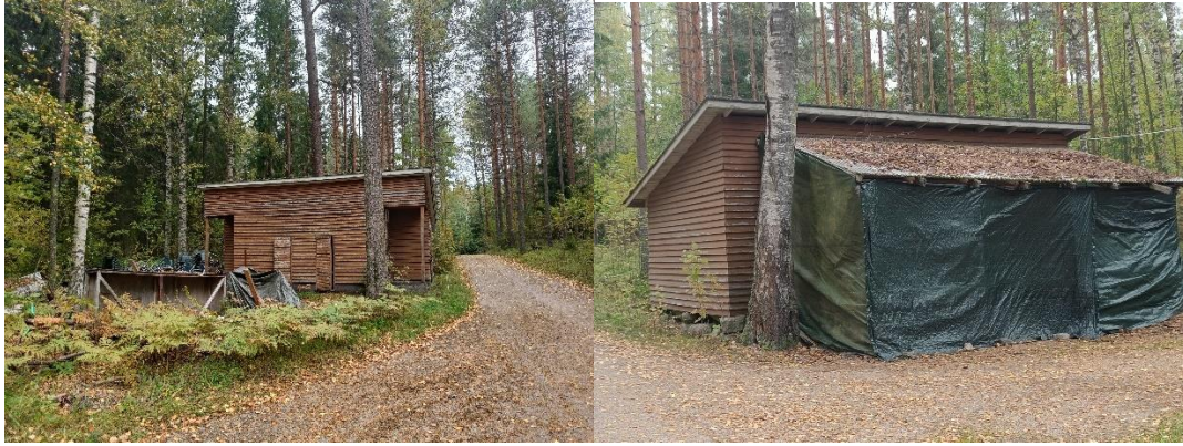
Eteläisemmän parakin ulkorakennukset
